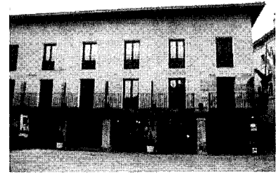
サント・ドミンゴ・デ・ラ・カルサーダのパラドール正面
