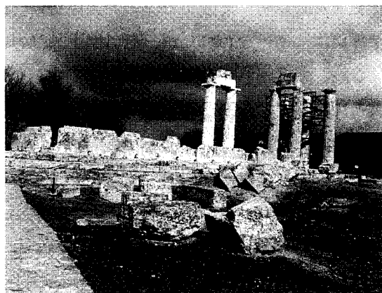
(11) 復元工事中のゼウス神殿
